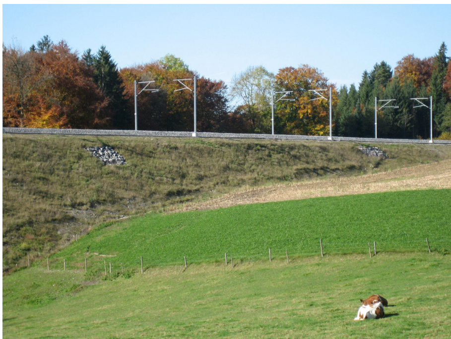
Figure 4 empierrement affleurant aménagé sur un talus ferroviaire
