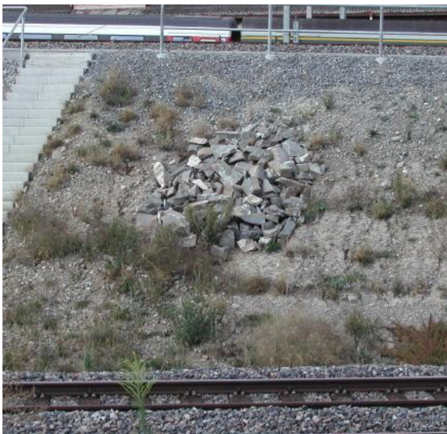
Figure 3 empierrement affleurant aménagé sur un talus ferroviaire
