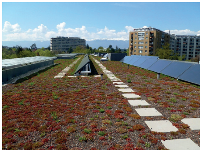
Figure 9 : Une toiture végétalisée extensive avec un recouvrement végétal non optimal constitué presque uniquement d'orpins (HEPIA / E. Renaud)
