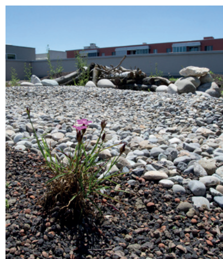
Toitures végétalisées avec des aménagements associés pour la faune et la flore.
