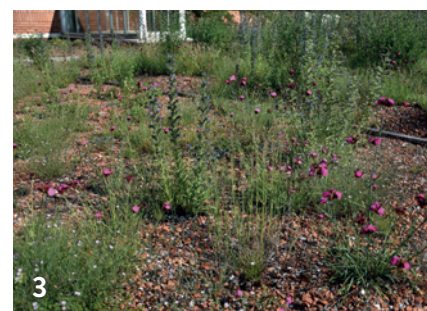
Figure 11 : Sur une même toiture, des variations d'épaisseurs de substrat (1 = 24 cm, 2 = 18 cm et 3 = 12 cm) vont influencer l'expression du mélange de graines initial (©HEPIA/ P. Prunier).
